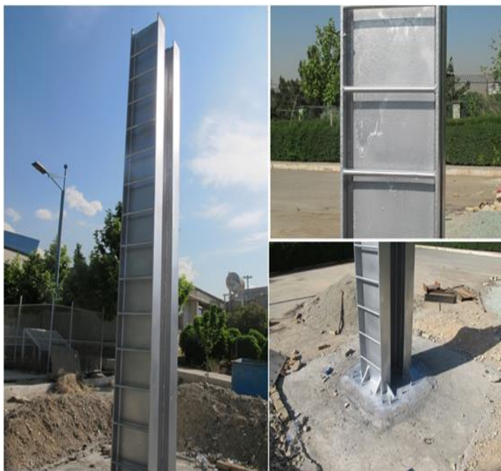
شکل ۷: نمایی از ستون نصب شده متمرکز کننده
