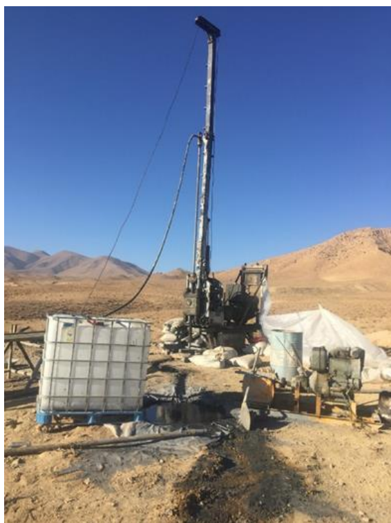
شکل ۲- تصویری از دستگاه حفاری گمانه‌های شیب حرارتی زمین گرمایی در منطقه محلات
